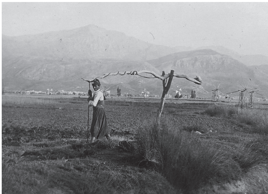
Το Γεράνι, ένας παλιός μηχανισμός άντλησης ύδατος στον κάμπο του Λασιθιού. Στο βάθος διακρίνονται ξύλινοι και μεταλλικοί αντλητικοί ανεμόμυλοι. Φωτογραφία 1931.
